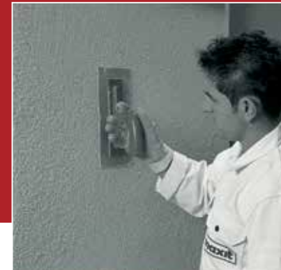
4. Verreiben des Oberputzes
