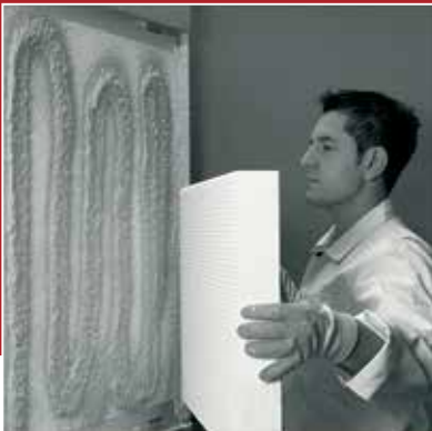
1. Aufbringen der Dämmplatten
