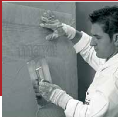
2. Armierungsschicht inkl. Gewebe
